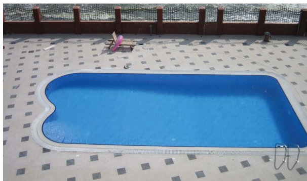
Монтаж: компания «ПИК Энергоинвест», Одесса
