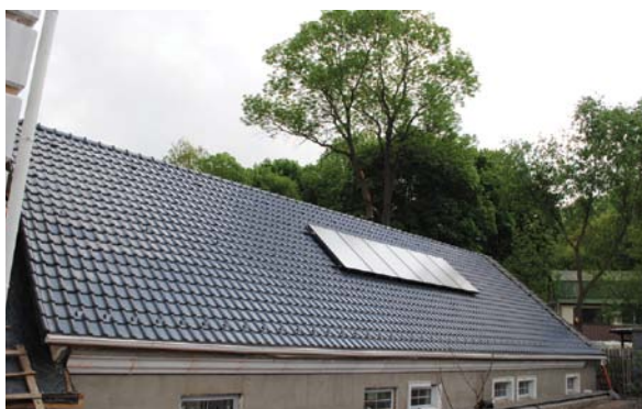
Монтаж: компания «Темос», Киев
