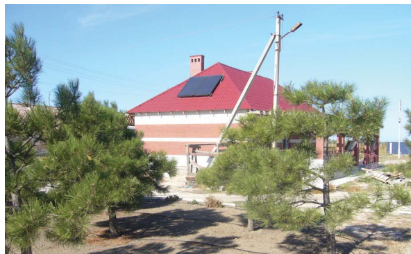
Монтаж: компания «Мега-Сервис Бердянск», Бердянск
