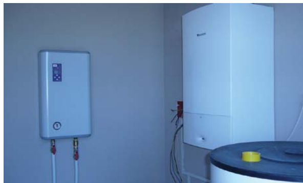
Монтаж: компания «Мега-Сервис Бердянск», Бердянск
